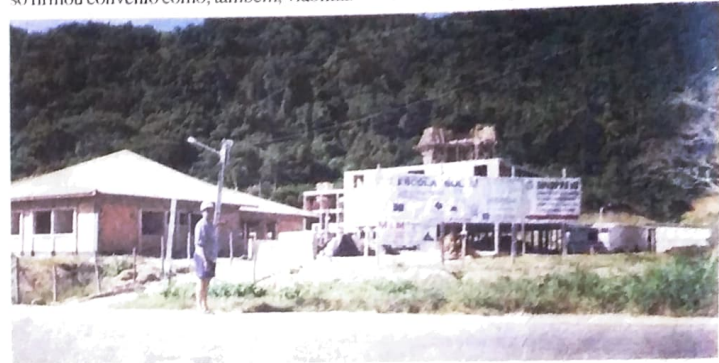
Construção do prédio onde funcionará a Escola Sul da CUT
